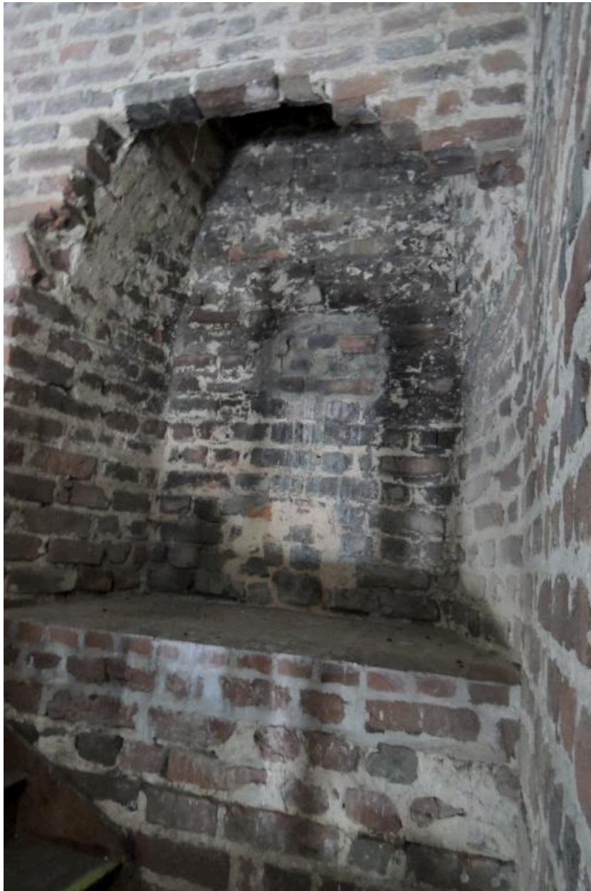
Donjon : intérieur, mur nord, niveau 3, cheminée.
