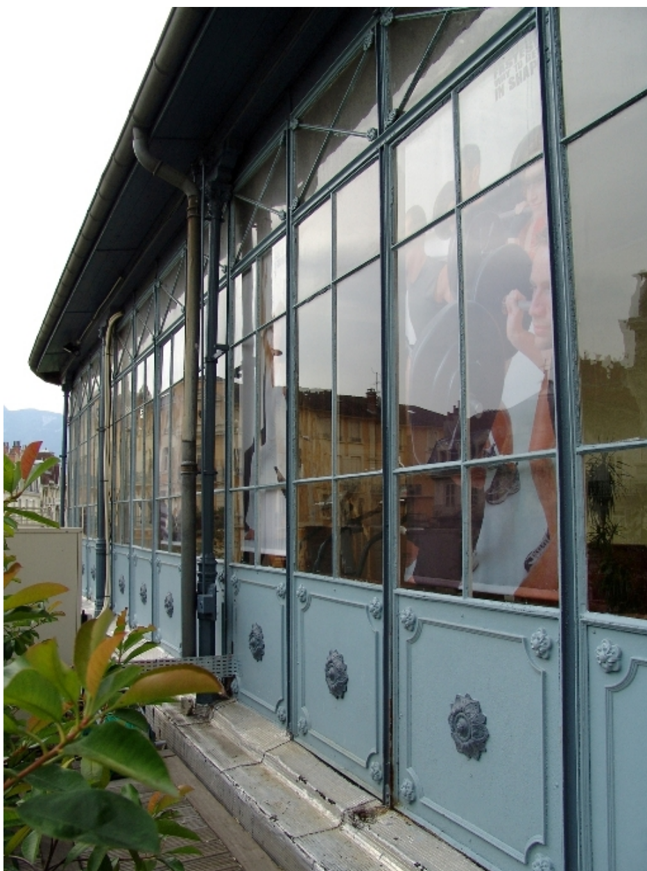
Véranda sur terrasse sud
