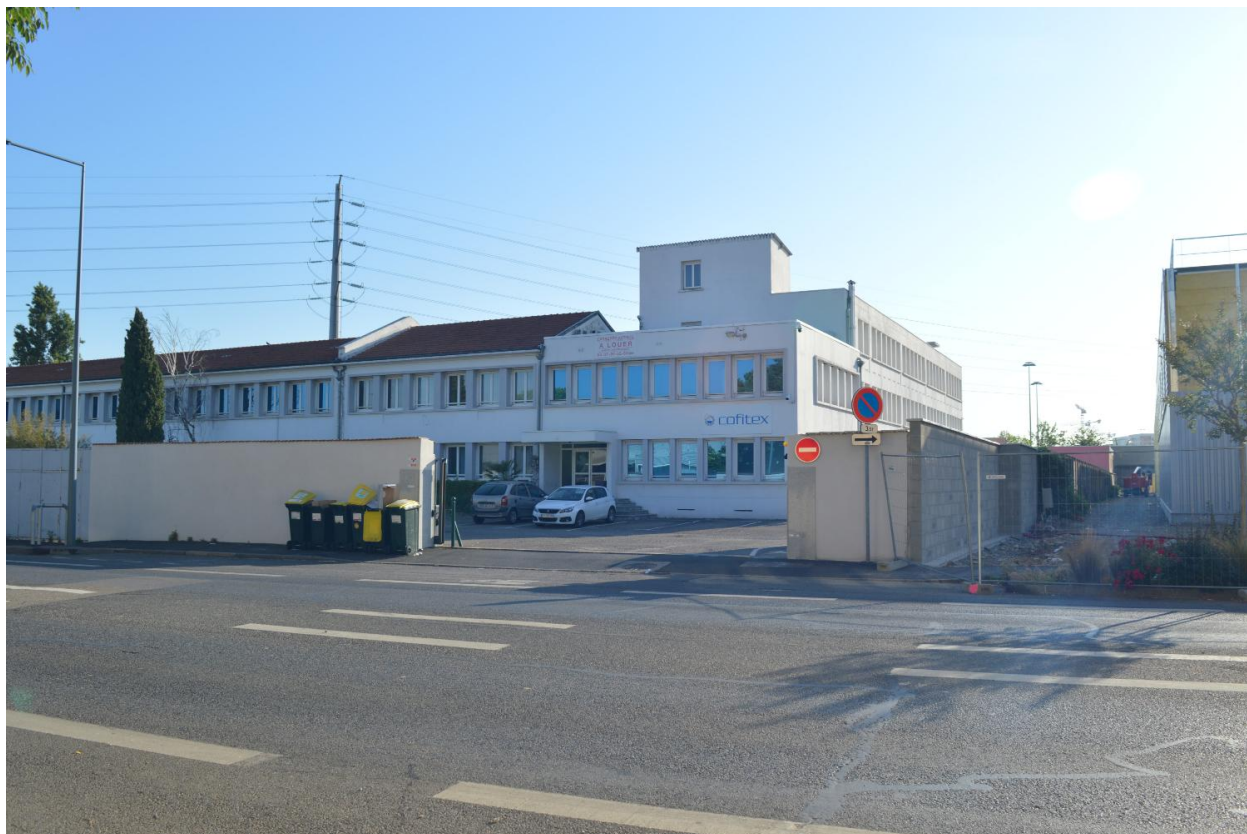
Entreprise Cofitex (ingénierie) - vue depuis l'avenue Francis de Pressensé - mai 2022
