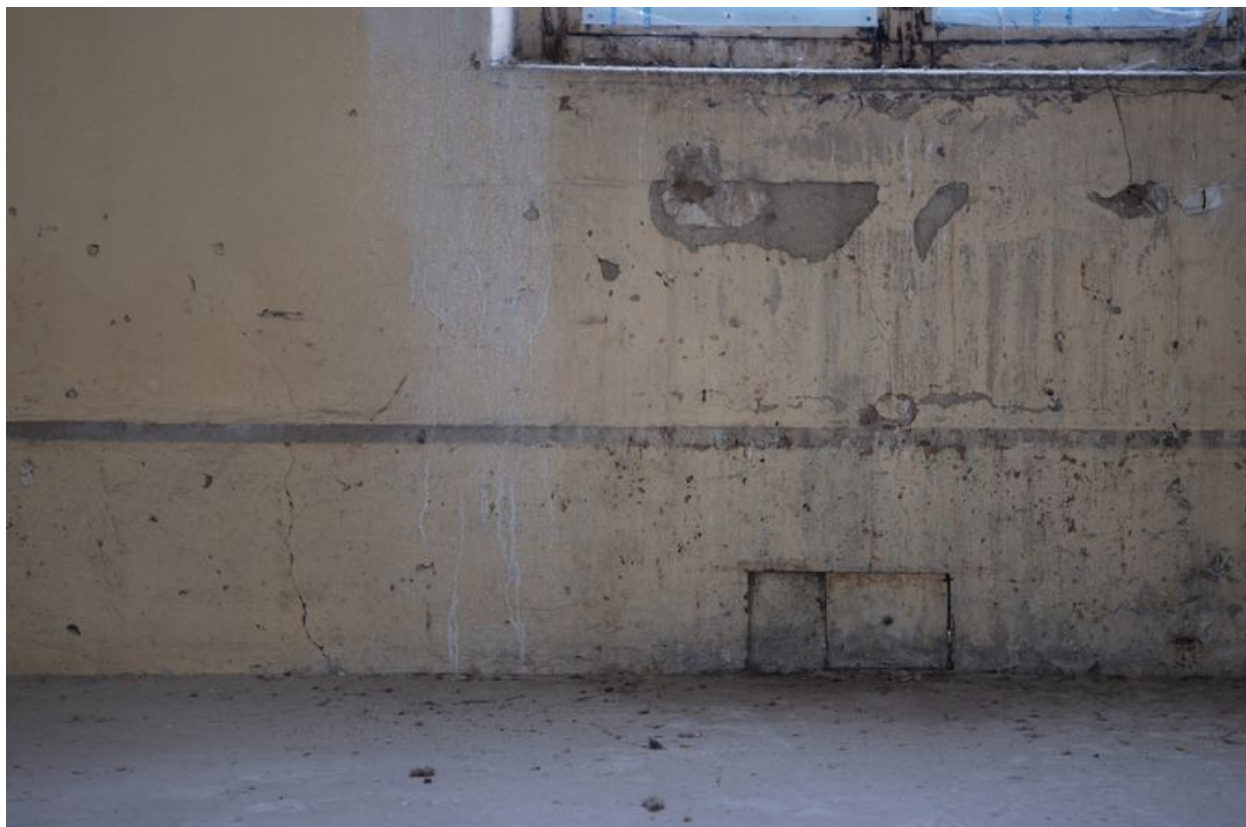
Second étage, salle désaffectée, détail d'une trappe
