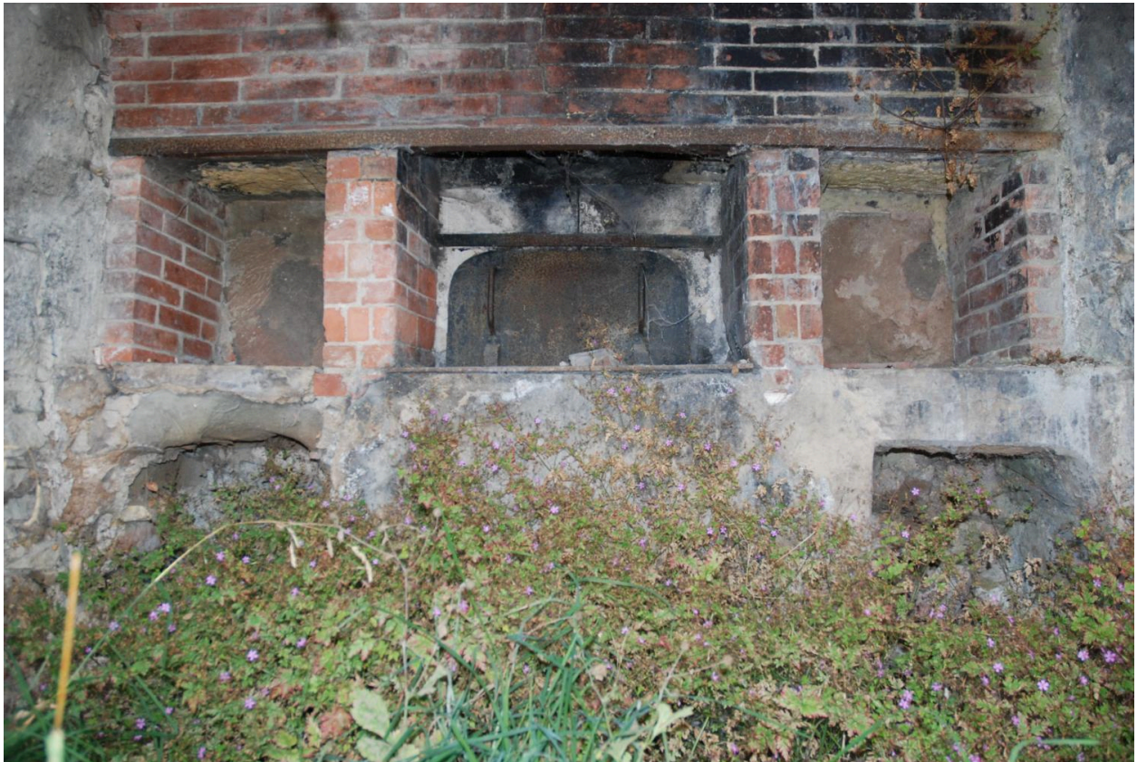
Vue de l'entrée du four.
