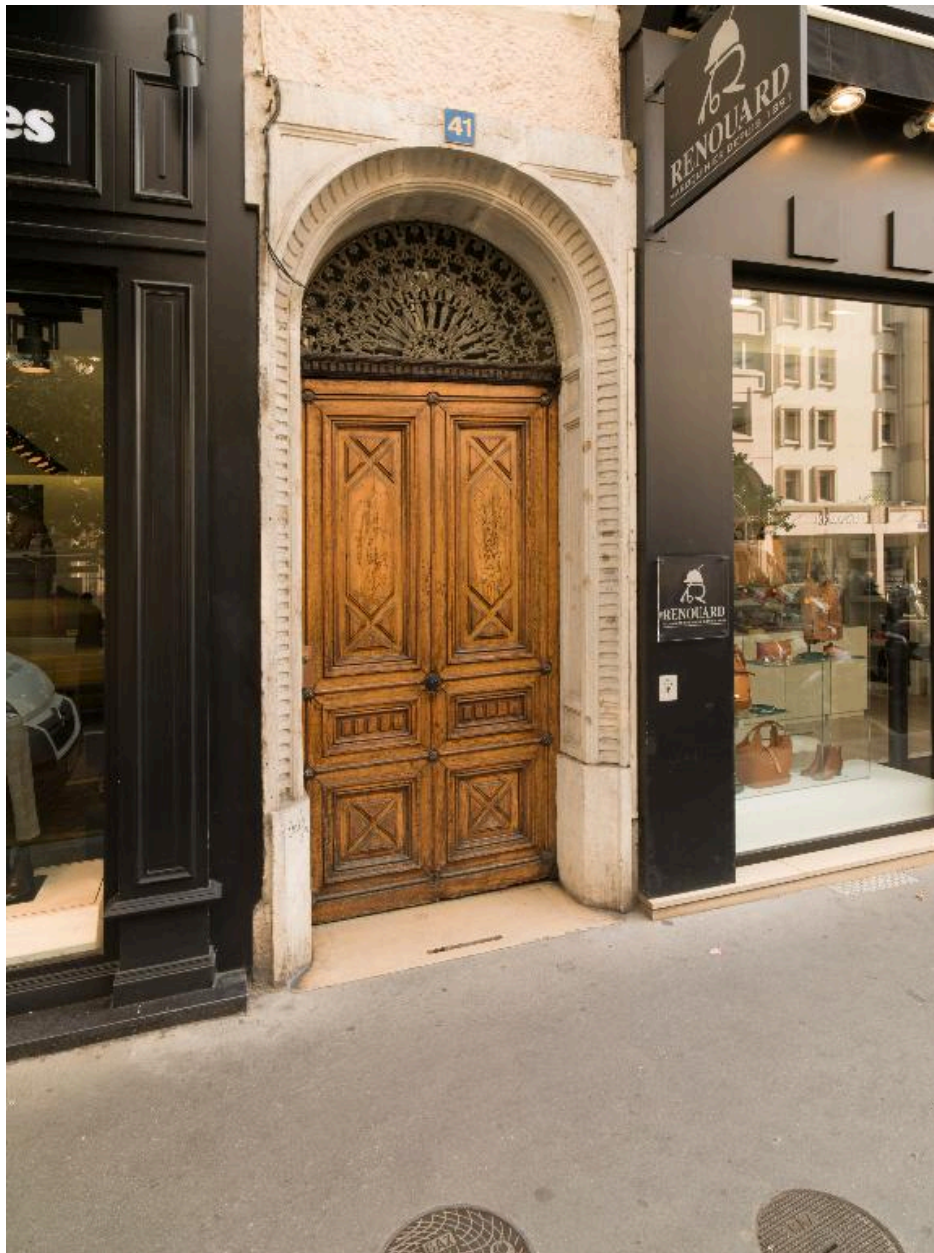
Elévation antérieure : la porte bâtarde
