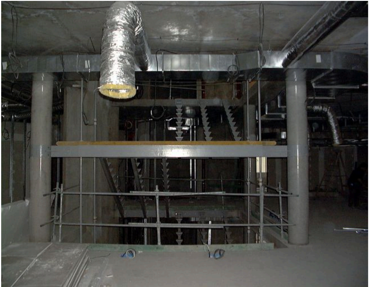
L'escalier en cours de construction, 23 mars 2000
