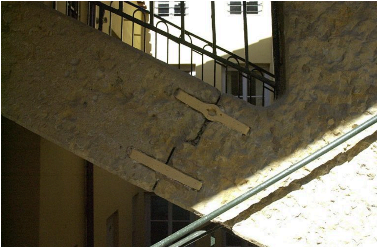
L'escalier : assemblage des pierres formant le limon
