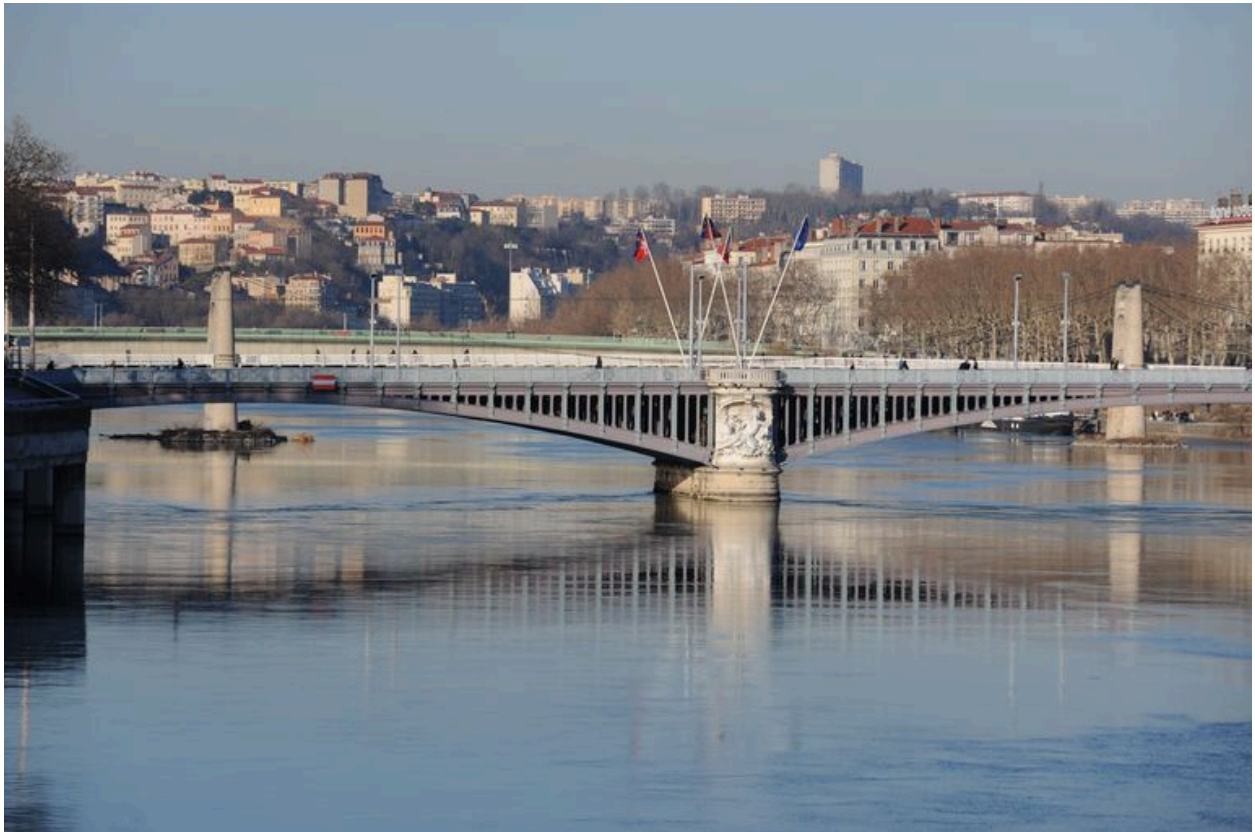
Vue partielle, pile, face aval (depuis la rive droite)
