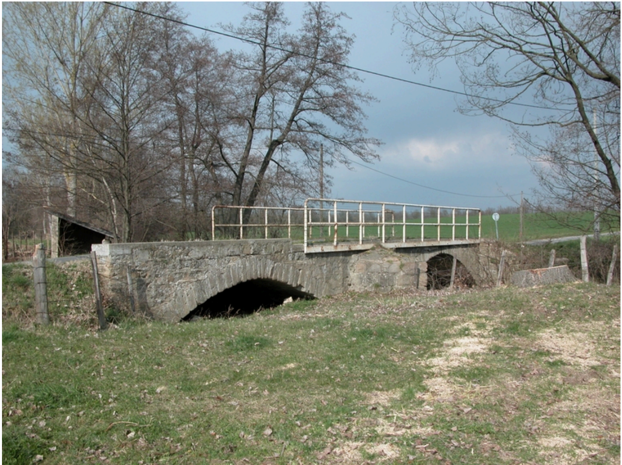
Vue du pont sur le Moingt à Crémérieux (1997 AS non cadastré, vers AS 40).
