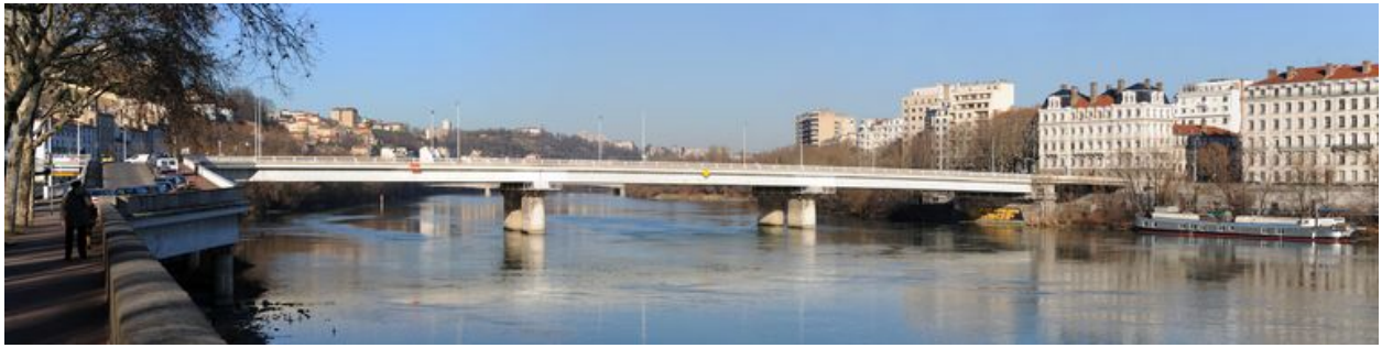
Vue panoramique, face aval (depuis la rive droite)
