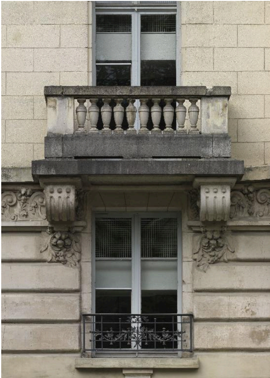
Façade sur cour: baies de l'entresol et du 1er étage
