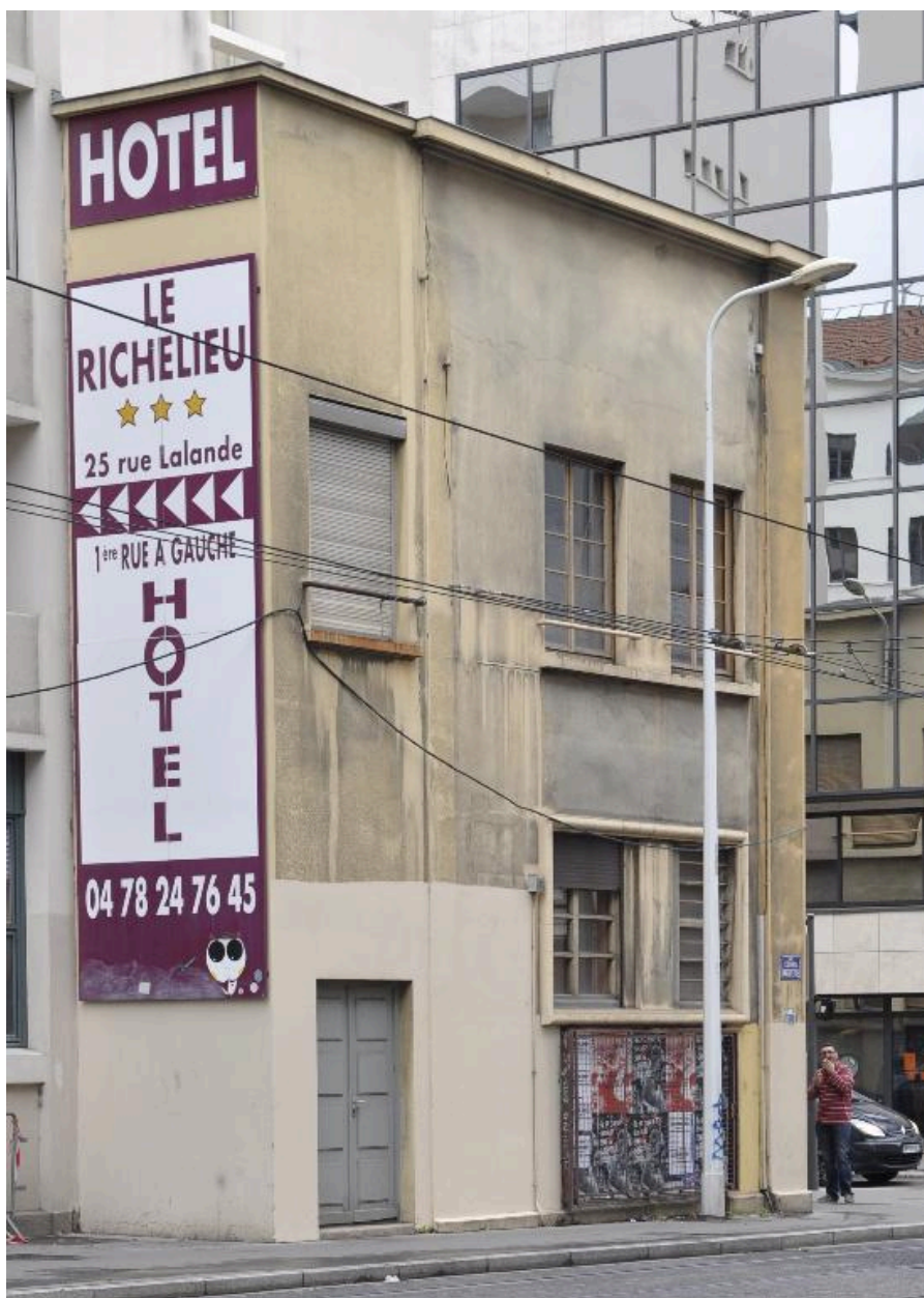
Vue sur la façade sud
