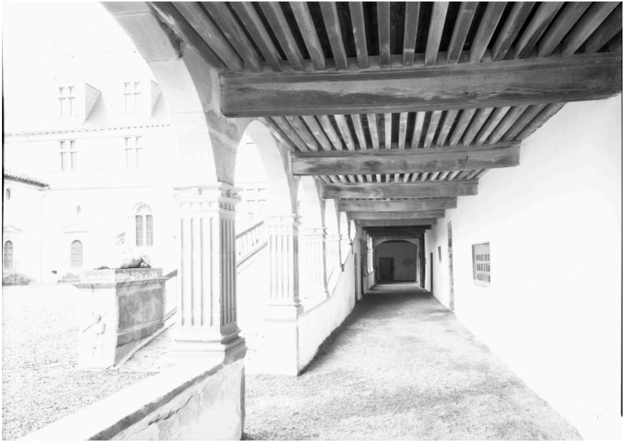
Corps de galerie, rez-de-chaussée : vue du portique au niveau de la rampe, du nord.
