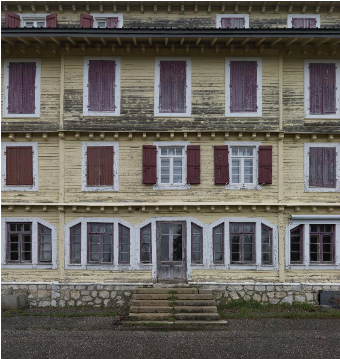
Détail de la façade principale : entrée donnant accès à l'ancienne salle à manger
