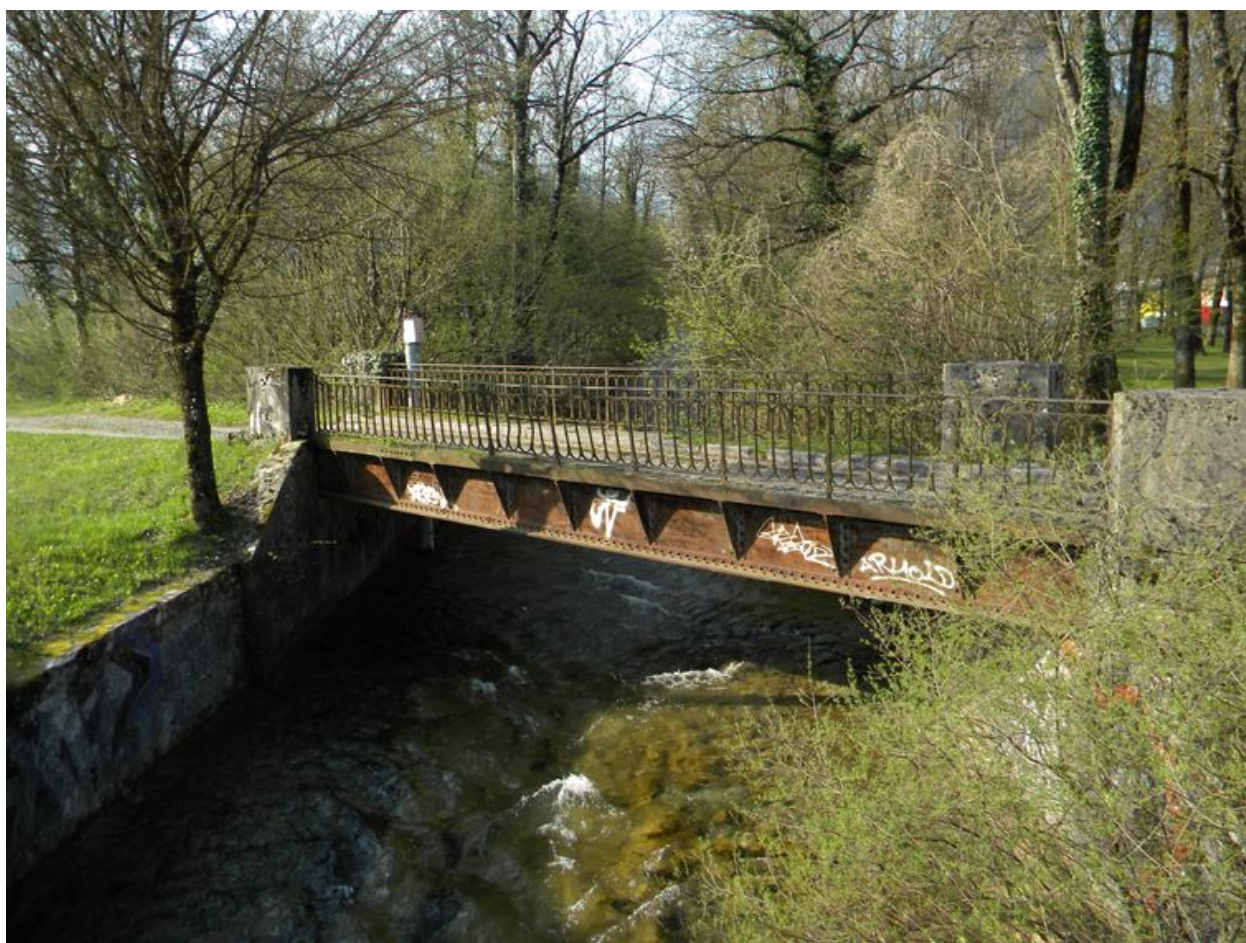
Vue du pont de chemin de desserte.
