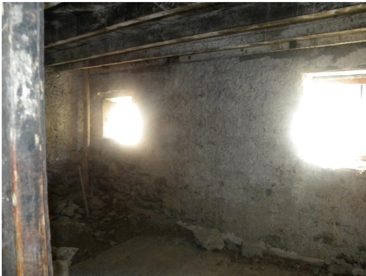
Vue de l'ancienne chambre.
