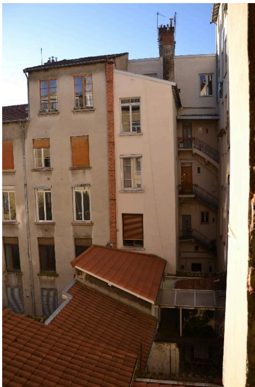
Façade arrière et escalier
