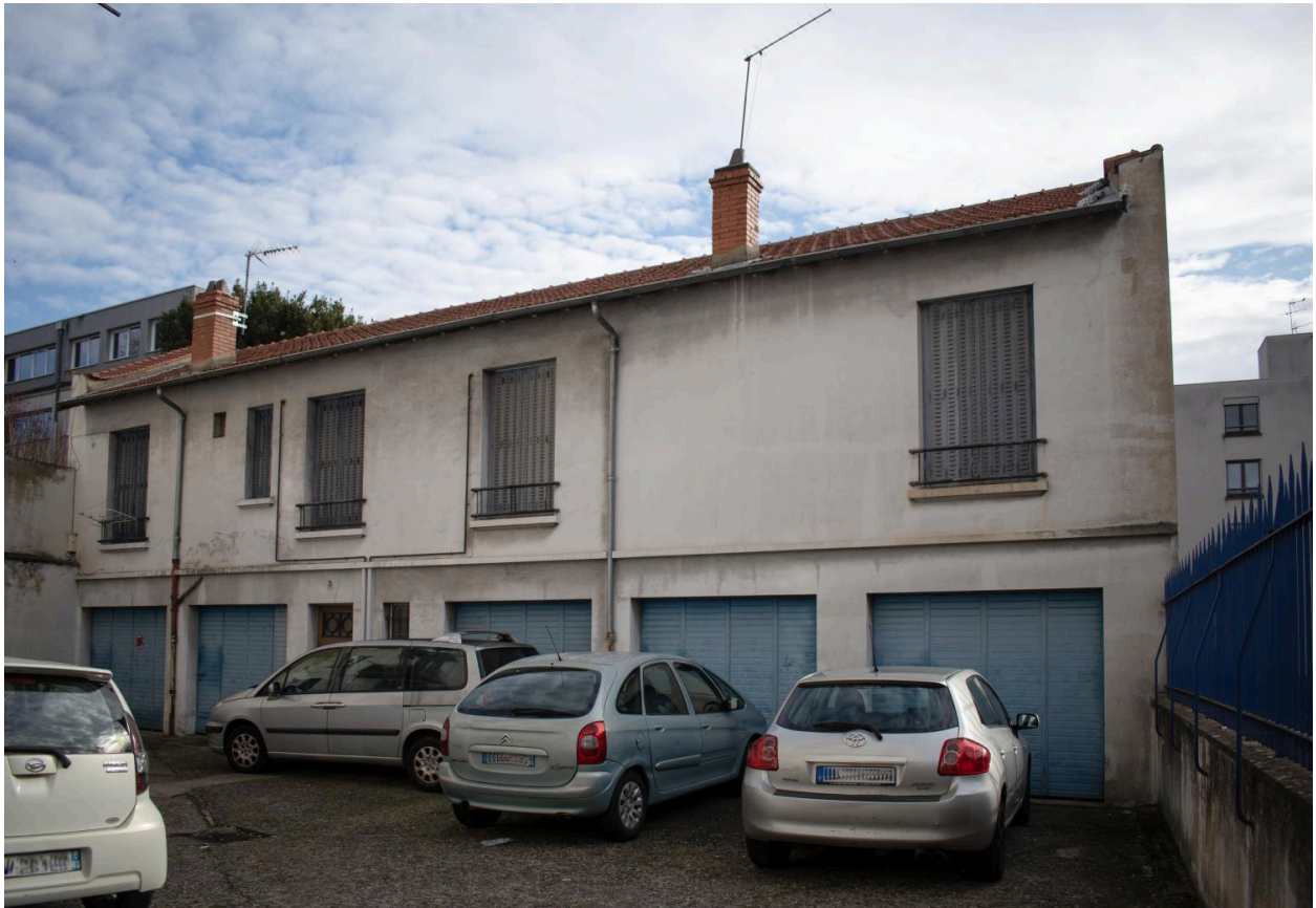
Maison en fond de cour, garages en rez-de-chaussée
