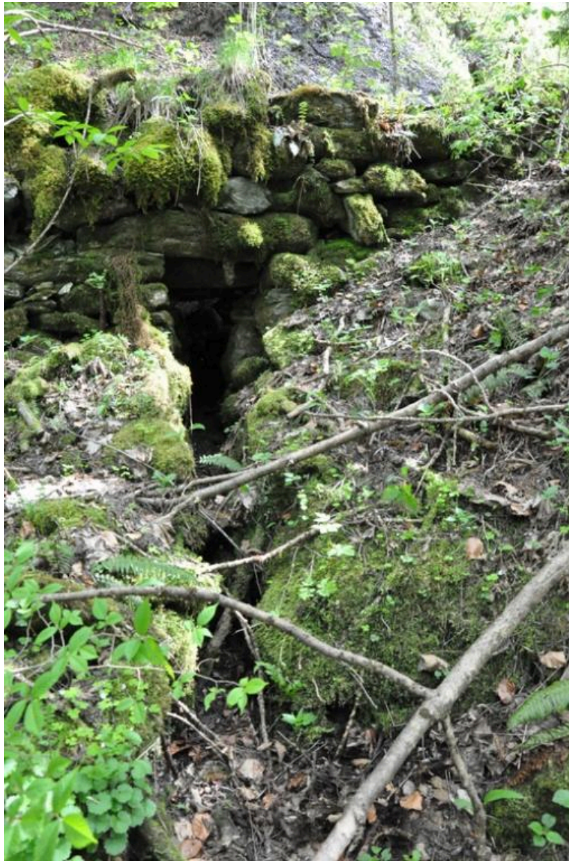
Canal de fuite du moulin amont.
