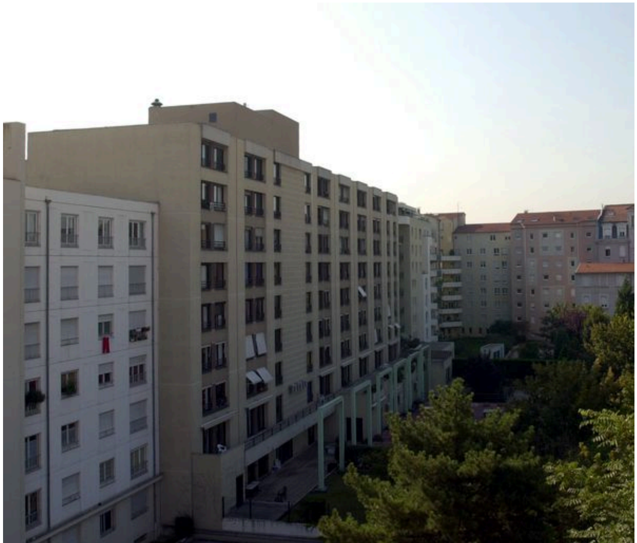
Elévation postérieure, depuis le nord
