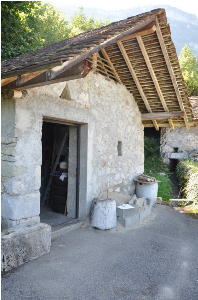
Vue nord du moulin amont
