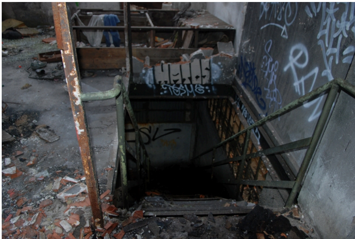
Escalier desservant le sous-sol
