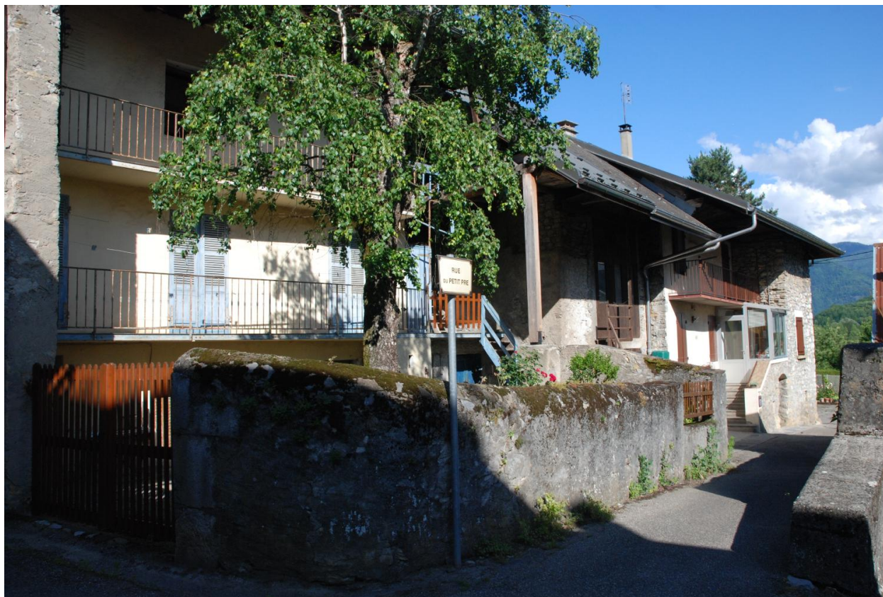
Maisons de vigneron le long de la rue du Petit Pré (2018 D3 730, 731).
