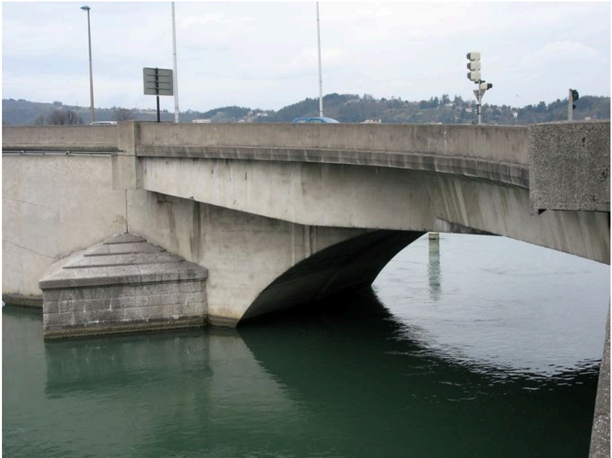
Rive gauche, extrémité du pont, face aval
