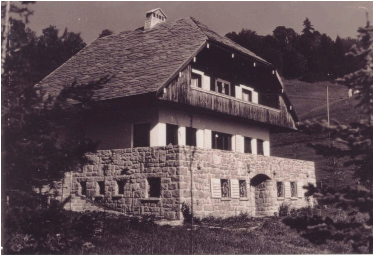
Vue d'ensemble depuis le sud-ouest. Photogr. Vers 1945
