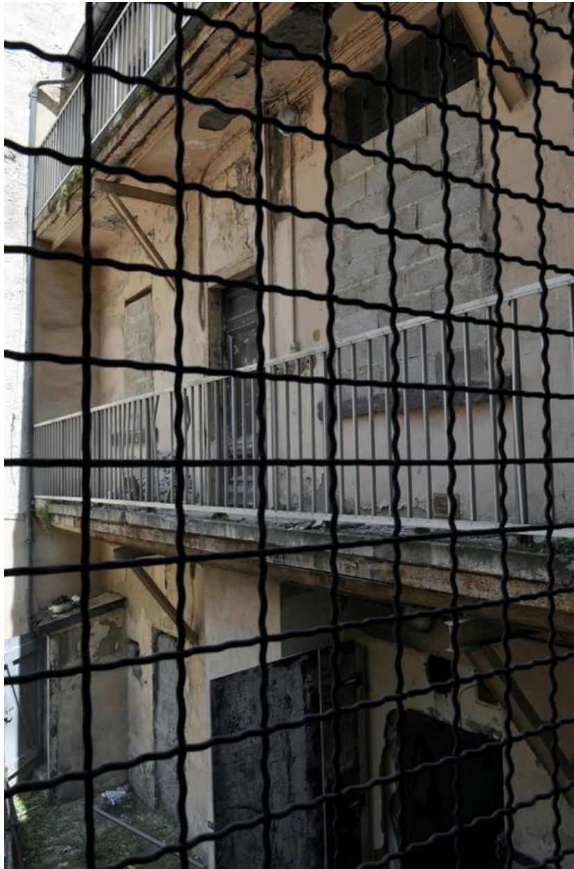
Coursières vues depuis la cage d'escalier
