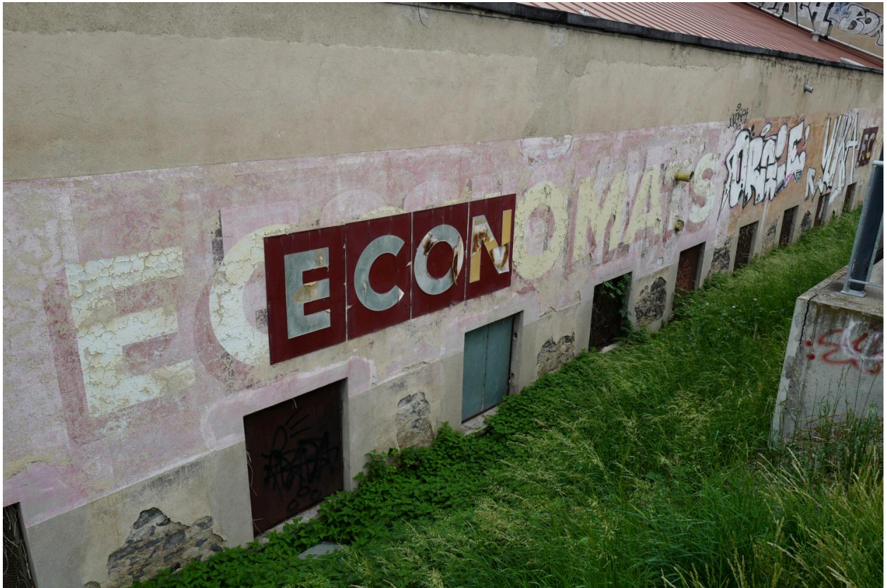
Vue depuis la voie ferrée
