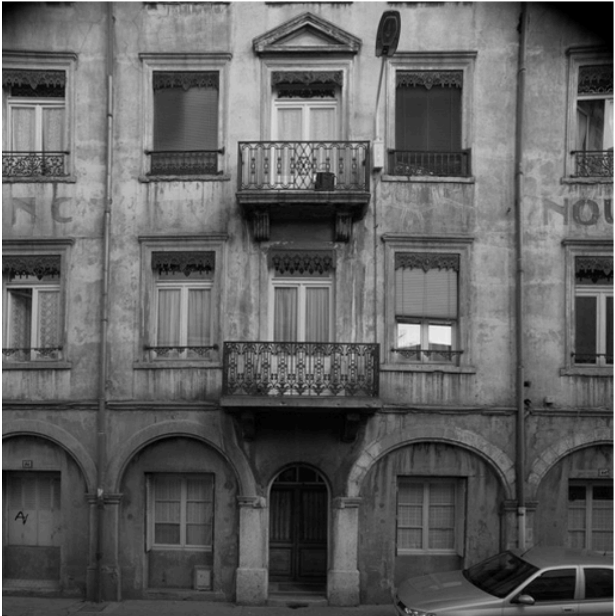
Entrée principale, ouest
