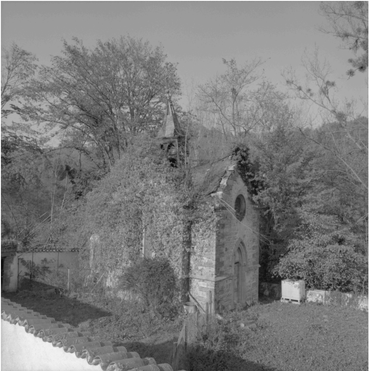
Vue d'ensemble de trois-quarts gauche, depuis le sud-ouest.
