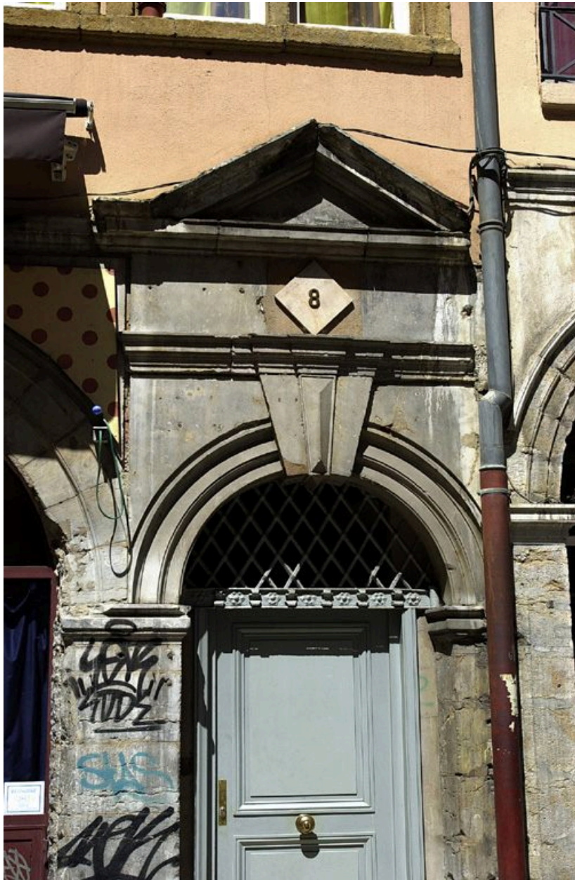
Elévation rue de la Monnaie : vue partielle de la porte
