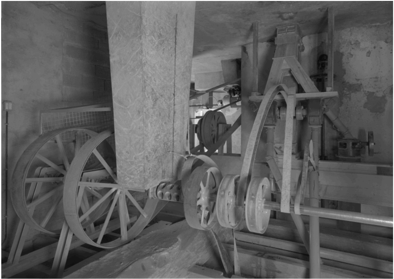
Etage de soubassement (sud) : courroies de transmission.
