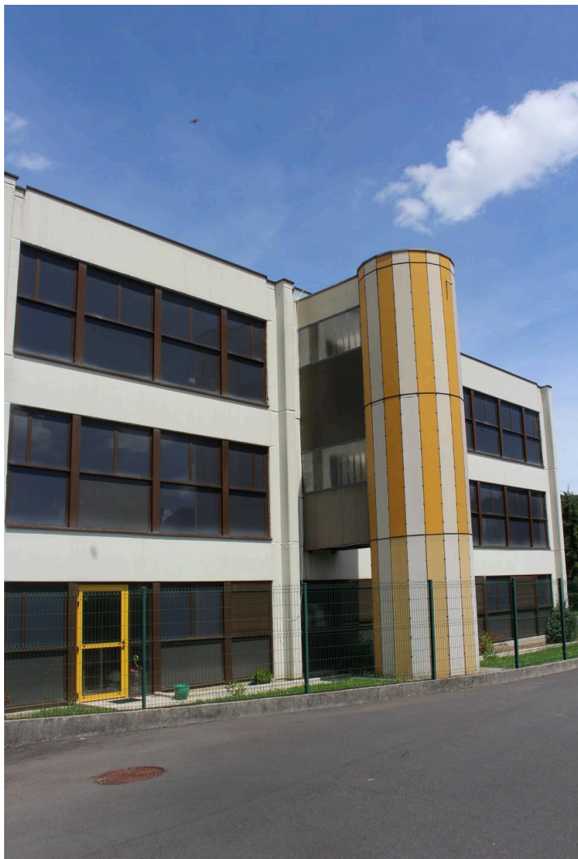
Détail de l'élévation postérieure avant travaux, en 2020
