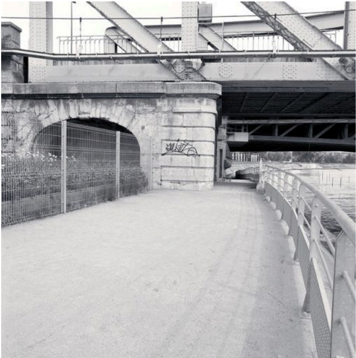
Arche maçonnée supportant le départ du pont
