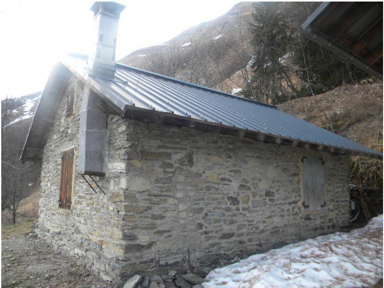
Vue de trois-quarts nord-est du bâtiment sud.
