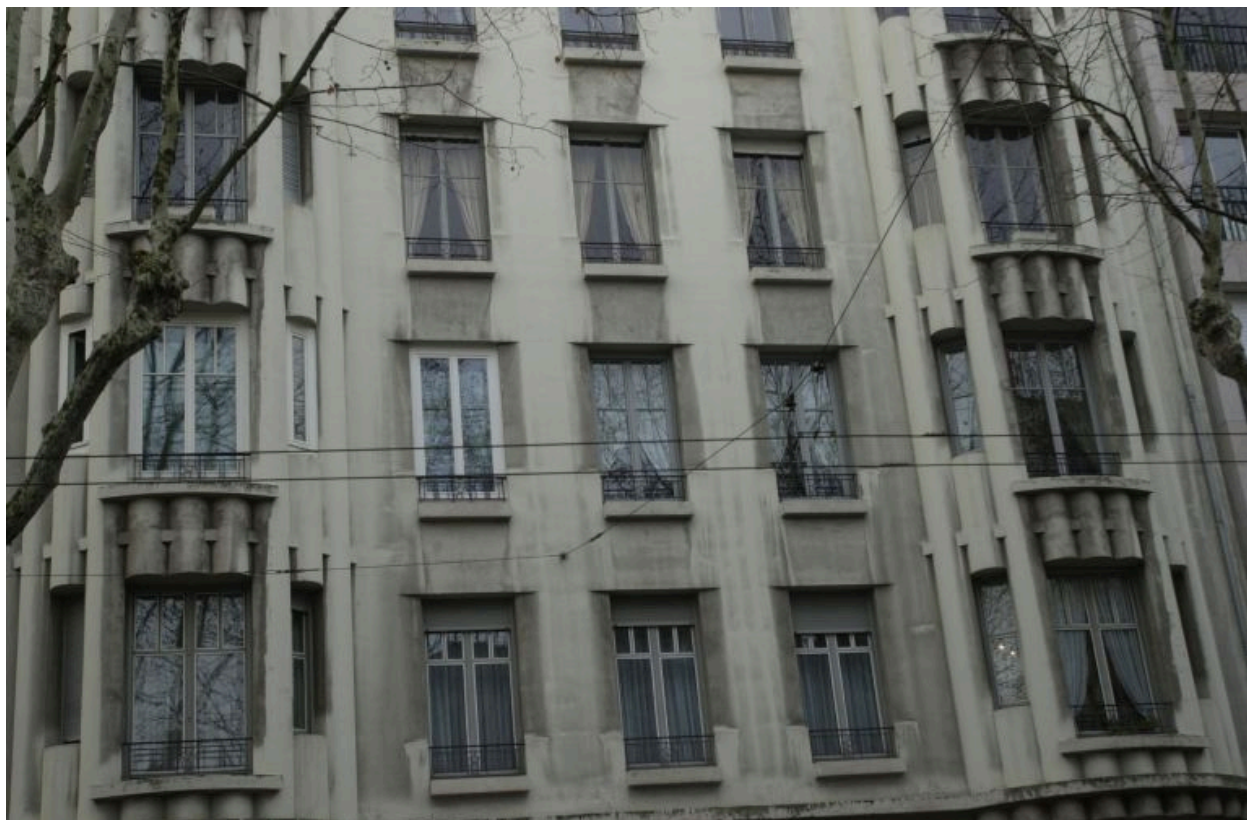
Détail de la façade boulevard des Belges
