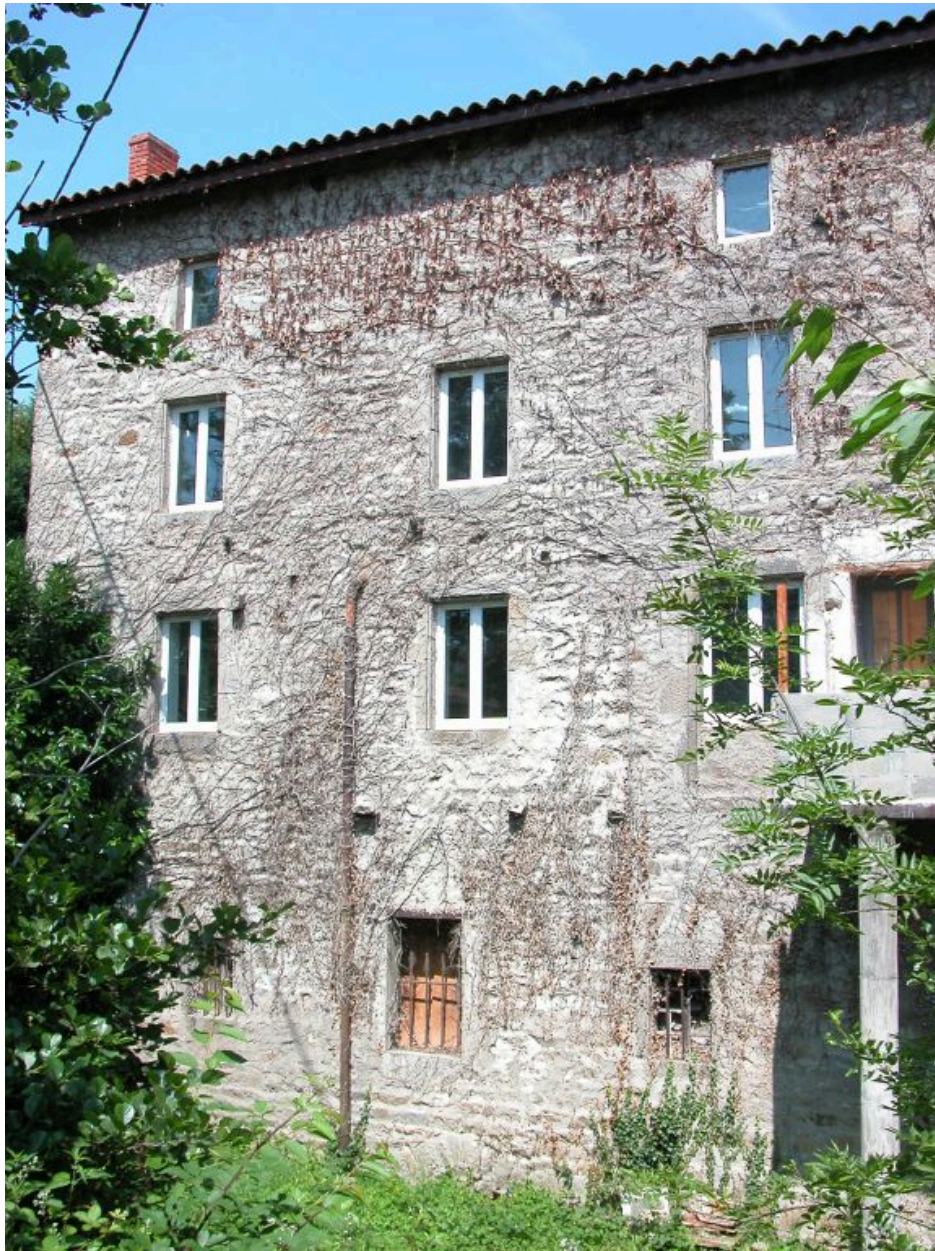
Travées du second corps de bâtiment, façade sud-est du moulin.
