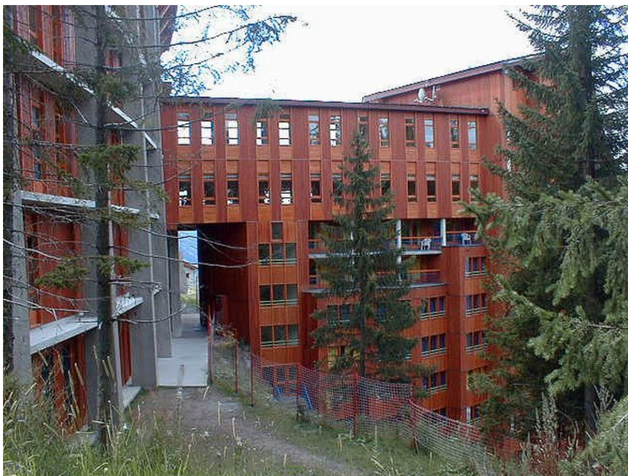
Façade nord-est, coursives et studios
