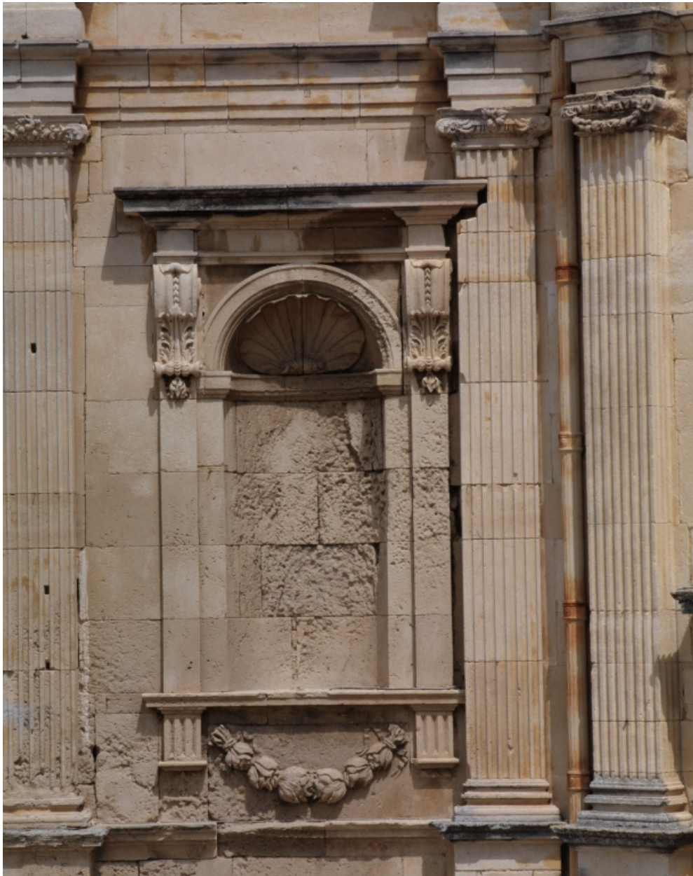
Bâtiment sud. Façade sur la basse-cour. Niche et ordre du rez-de-chaussée.
