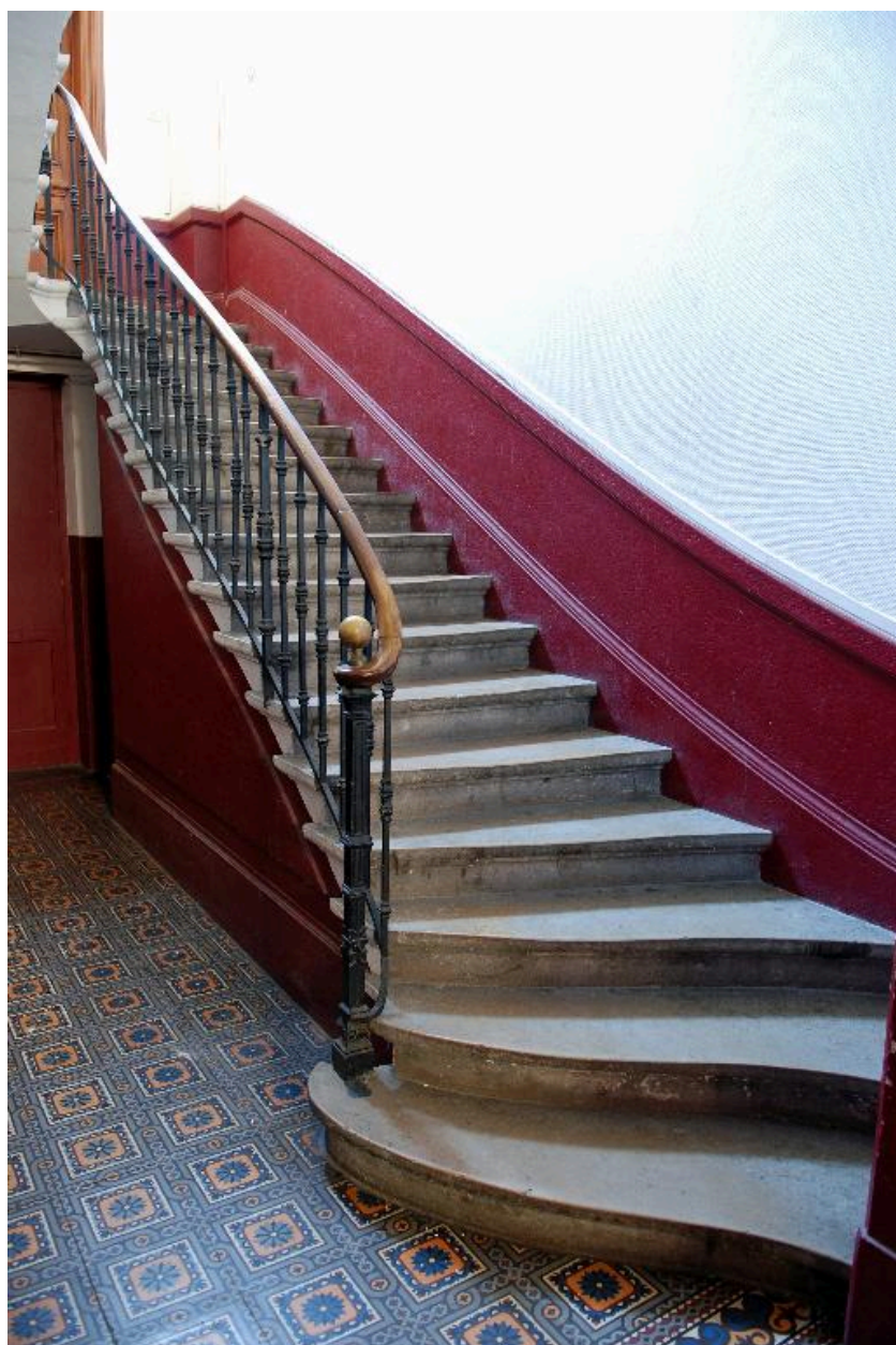
Vue intérieure : le départ de l'escalier
