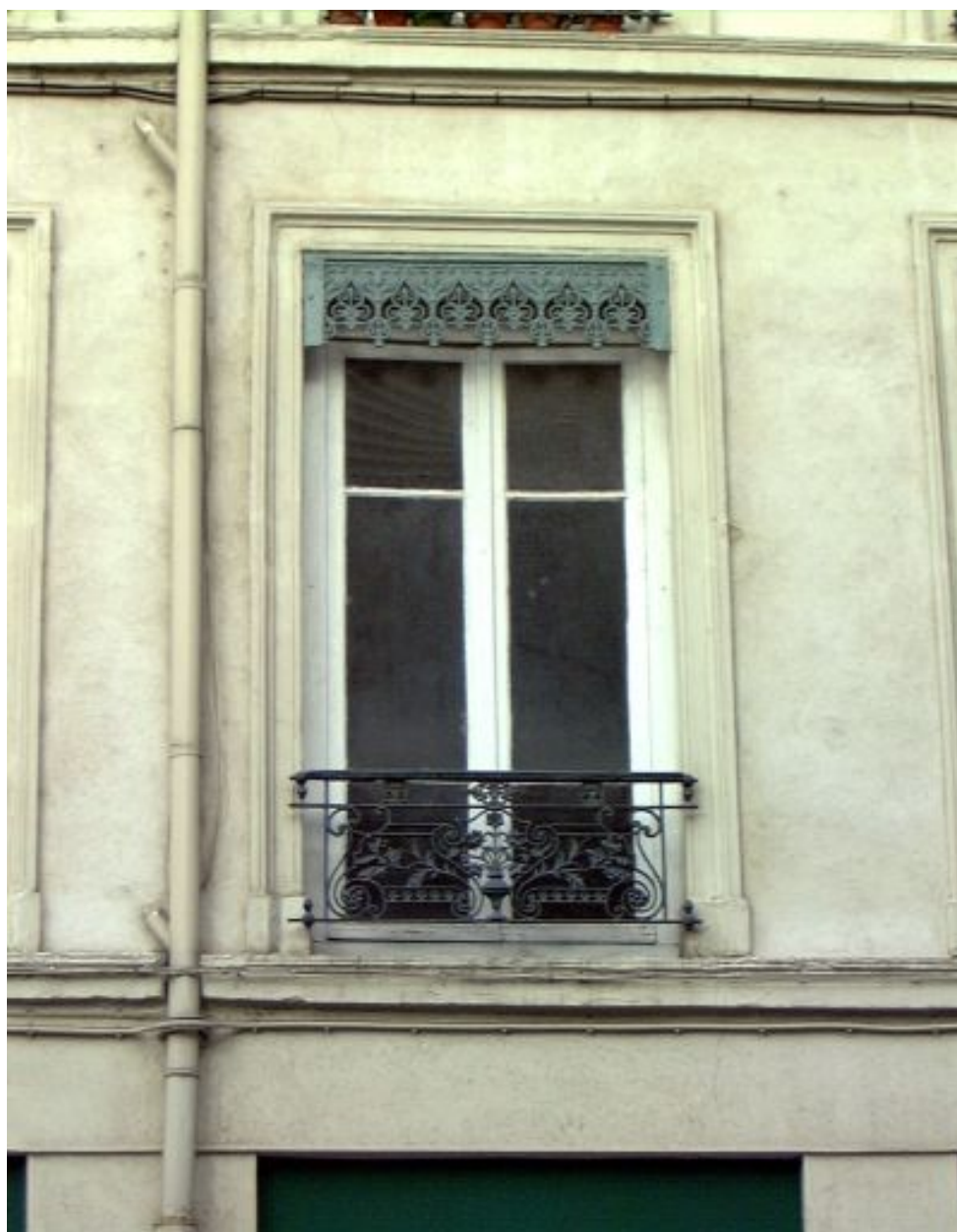
Détail d'une fenêtre rue Delandine
