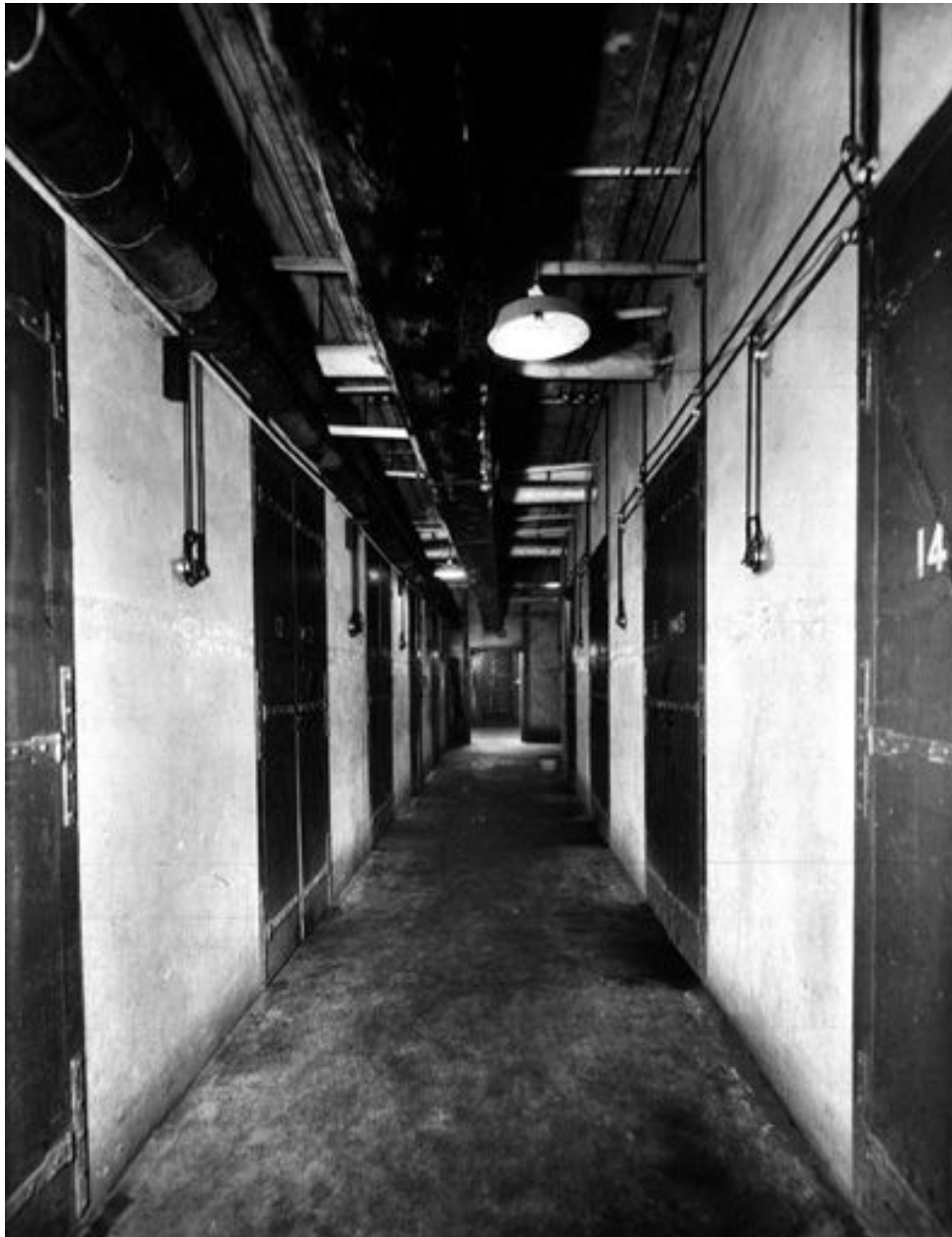
Couloirs de distribution des chambres froides (BM Lyon)
