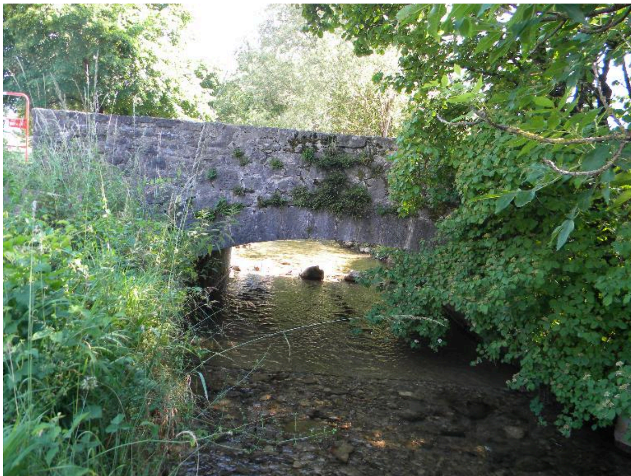
Vue depuis l'aval.
