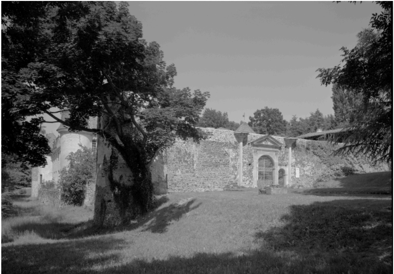
Vue générale de l'entrée principale, de l'est.
