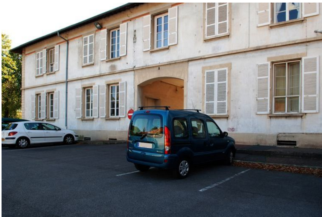
Cour nord, façade sud du bâtiment 231 (travailleurs hommes)
