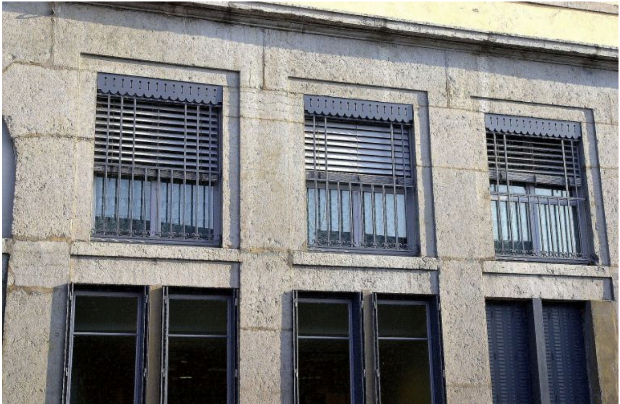
Détail des fenêtres de l'entresol, rue Dugas-Montbel
