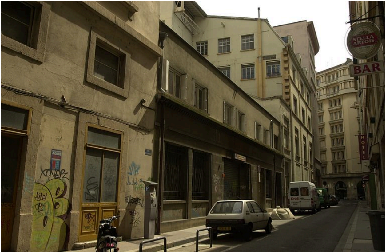
Façade du garage n°5, rue de Savoie
