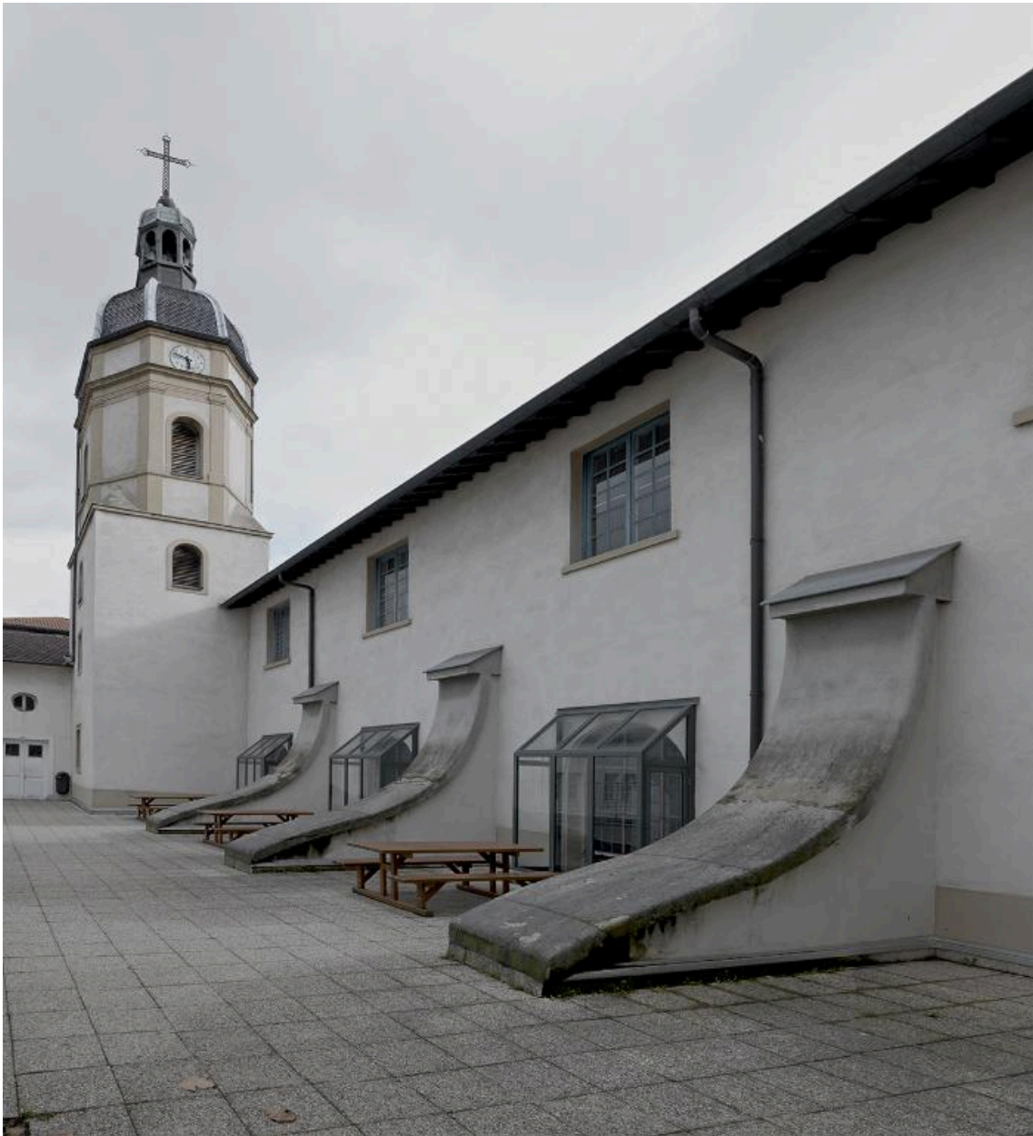
Le clocher et le flanc nord, vus depuis l'ouest
