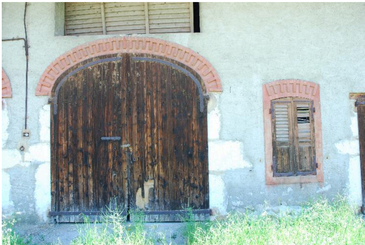
Détail de la façade avant de la grange-étable
