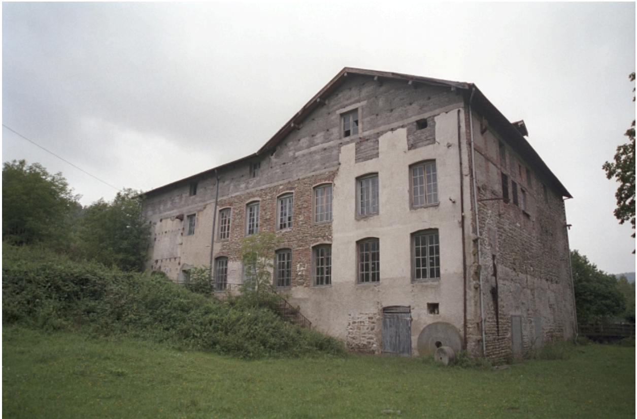
Vue d'ensemble des façades latérale gauche et arrière du moulin.
